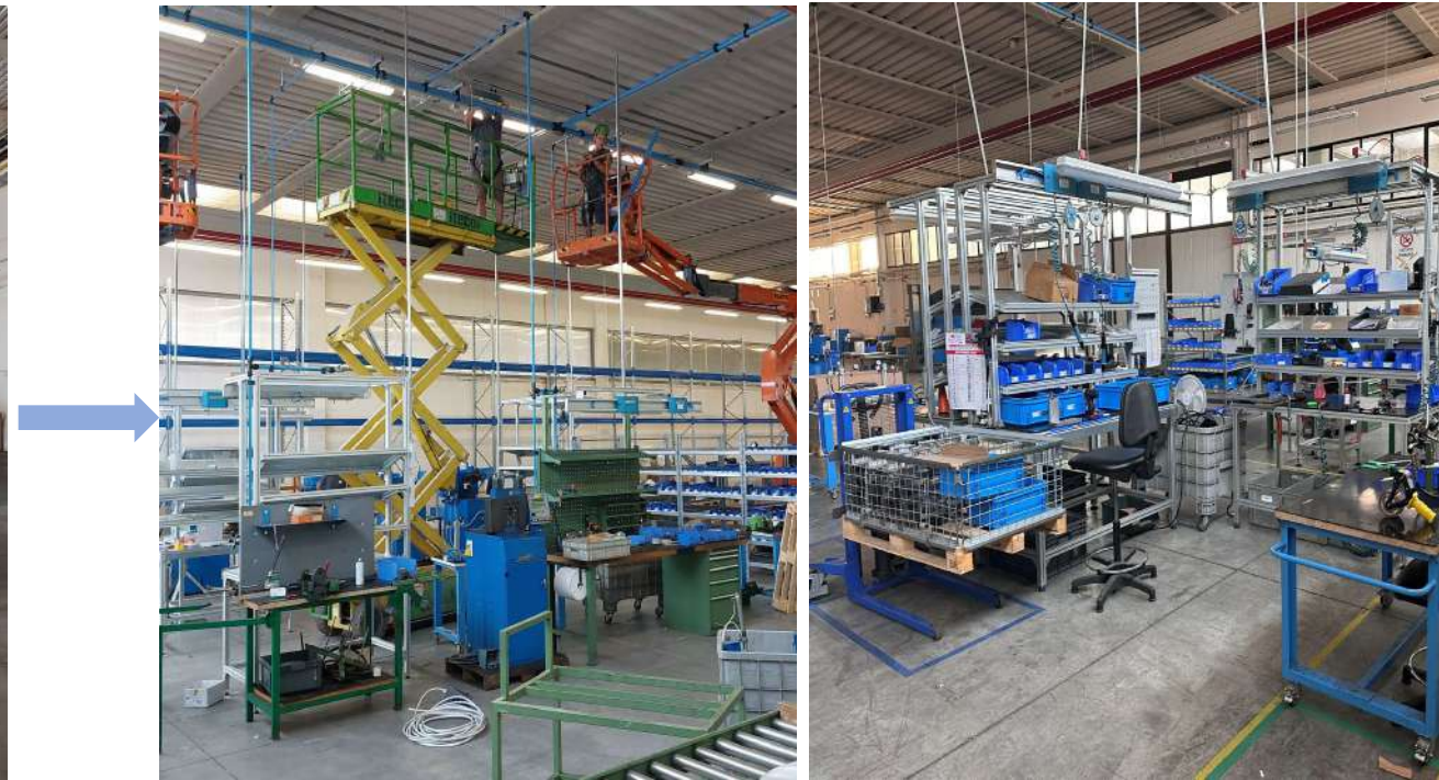
DOPO San Quirino - Montaggio
